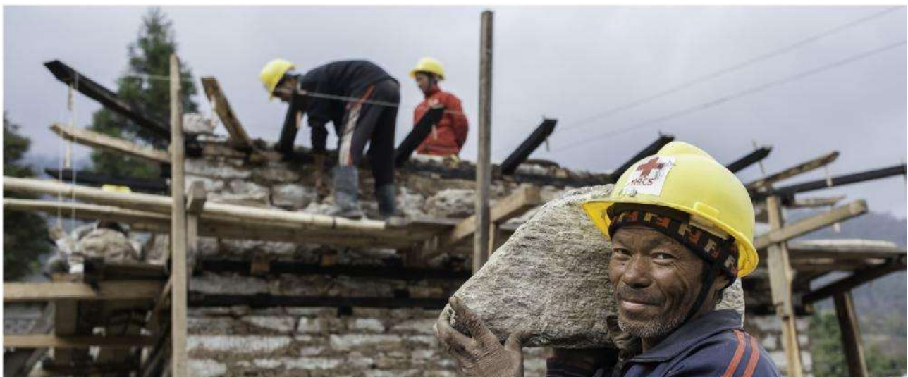
Pekerja konstruksi membangun rumah contoh di Desa Suspa Chhemawati, wilayah Dolakha, Nepal. Fotografer: Carlo Heathcote, IFRC
